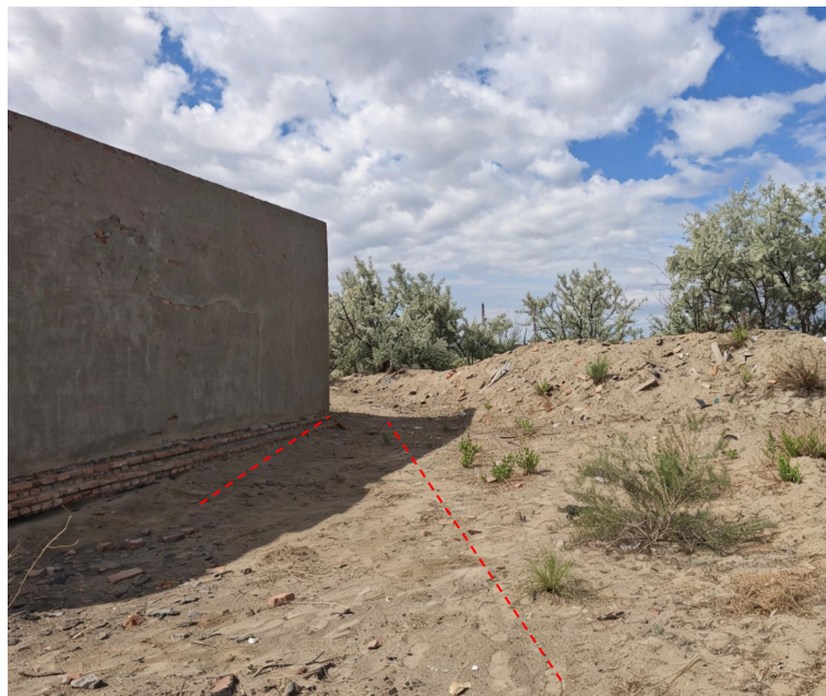
照片2 ZJHW1313、ZJHW1323两井平台+ZJHW1312、ZJHW1322两井平台电力线路-村庄用地
